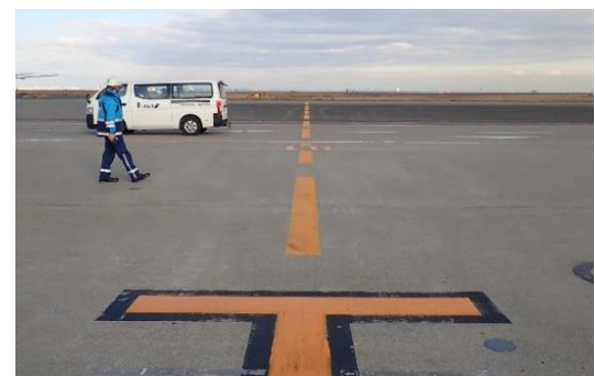
▲航空機導出線の新設
