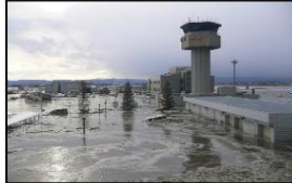
水没した空港事務所
