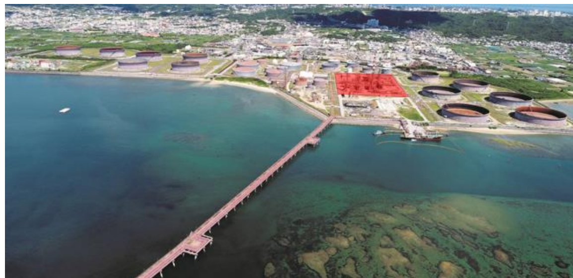
赤枠内:本事業における建設候補地
