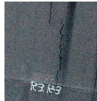
図-8 「1億画素カメラ」による令和3年に発見したひび割れの補修跡の撮影結果（高度30m）
