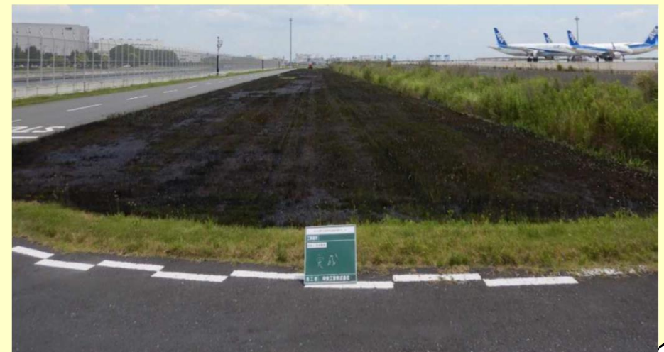
施工後(アスファルト乳剤散布)
