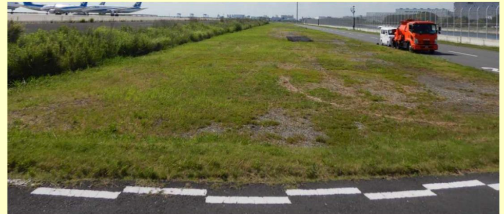
施工後(アスファルト乳剤散布)
