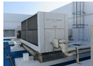
PAC室外機の設置
