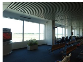
遮熱フィルムの設置
