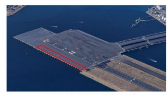
羽田空港D滑走路着陸帯(舗装部)
