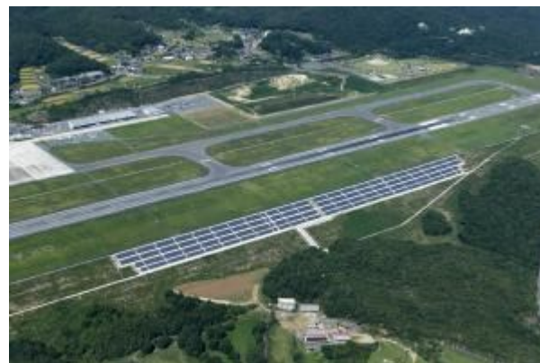
空港法面に設置されている太陽光発電
