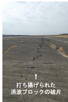
【④消波ブロックの破損】
