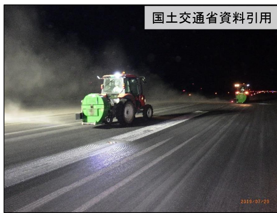
【除灰清掃作業中の様子】
