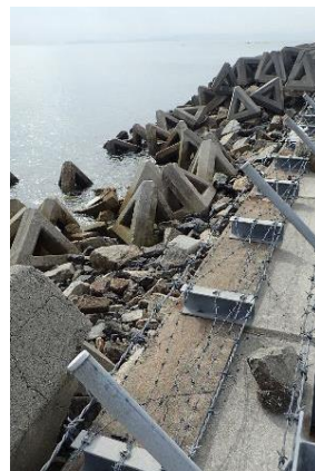
【④消波ブロックの破損】
