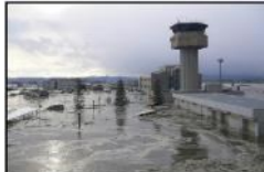
水没した空港事務所
