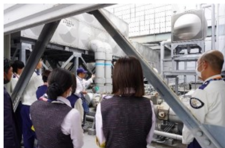
屋上配備の設備見学
