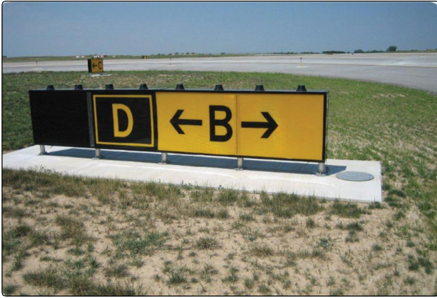
図 14-18. 誘導路Delta 位置標識が併置された誘導路Bravo 方向標識。方向標識の矢印が曲がり角を示している場合、標識は交差点の前にある。
