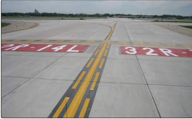
図 14-12. 表面に滑走路32R-14Lの待機位置標識が塗装された滑走路、および強化された誘導路中心線標示。
