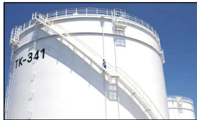
③貯油タンク
