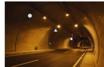
図 2.3-4 自己位置推定のための補助設備の例（ターゲットラインペイント）
