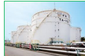
(貯蔵タンクの定期点検)
