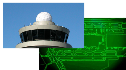
空港面監視レーダー (ASDE)
