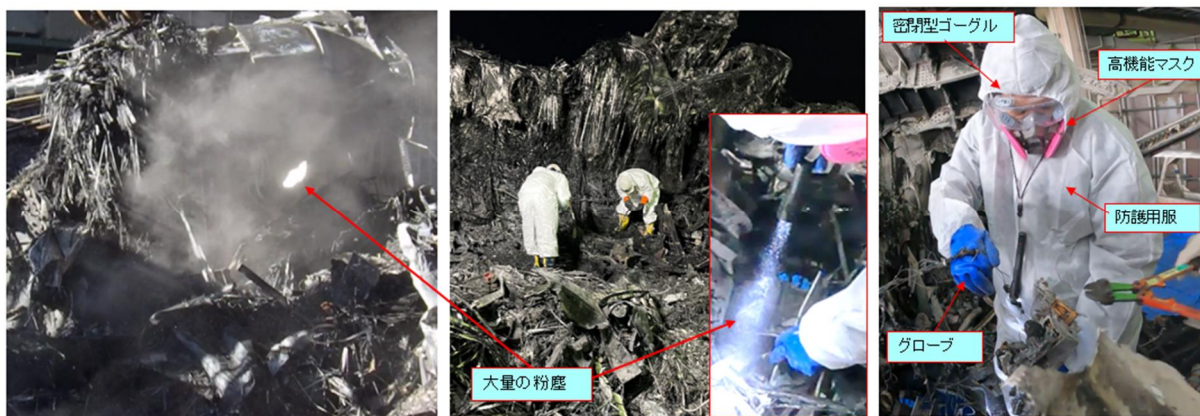
図 5 6 - 2 現場の状況（CFRP 粉塵、防護服）
