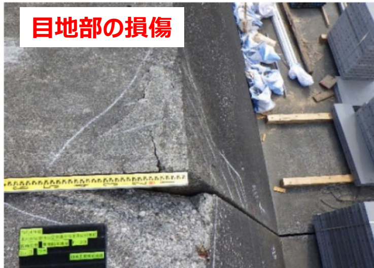
近接目視（定期点検記録）
