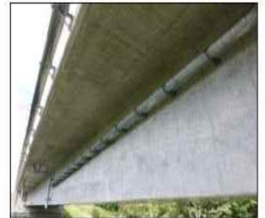
※地覆水切りが上床版までの打ち下ろしのため、横桁位置が確認できる。
