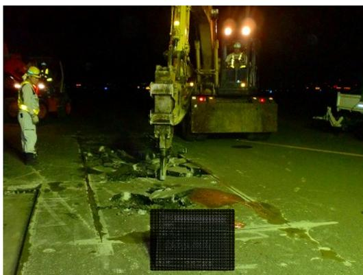
写真 5.1.5 舗装版撤去状況
