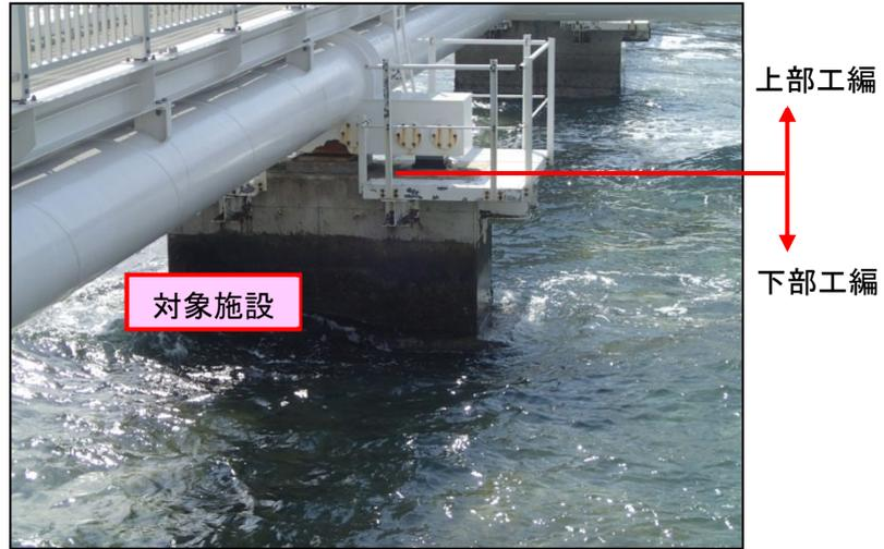
・北側進入灯(沖側) 杭式(海底地盤上：杭構造含む)
