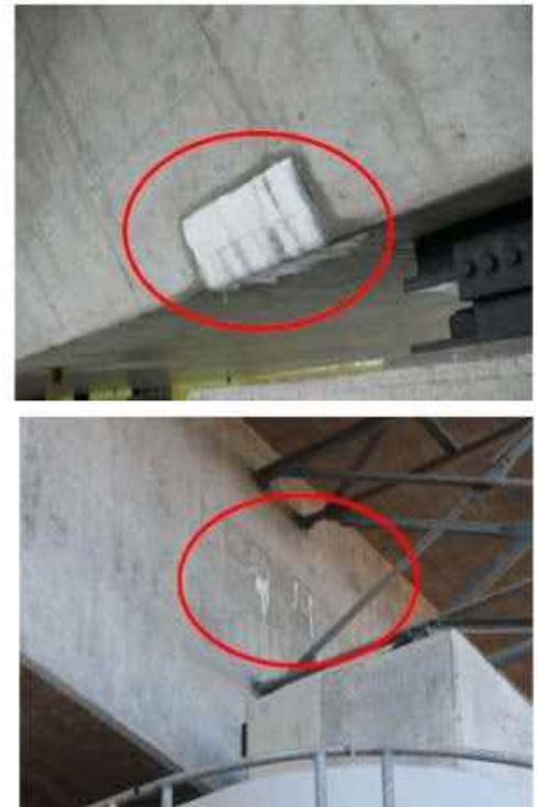
※地覆水切りが上床版までの打ち下ろしのため、横桁位置が確認できる。本事例では、縦締めは01番とし、横桁横締めが11番から始める。また、横桁横締めの下2桁は、横桁の部材番号と同じとする。第1径間：1101, 1201, 1103, 1203 第2径間・第3径間：1102, 1202
