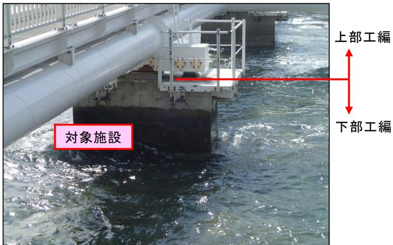
・北側進入灯(沖側) 杭式(海底地盤上：杭構造含む)
