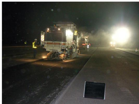
写真 5.1.16 切削施工状況
