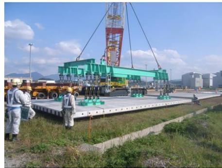
写真 5. 2. 27 PPC版の運搬状況
