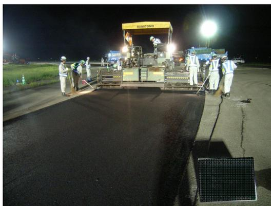
写真 5.1.18 舗装敷均し施工状況
