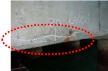
幅 3 mm未満の鉄筋軸方向のひび割れがある。
