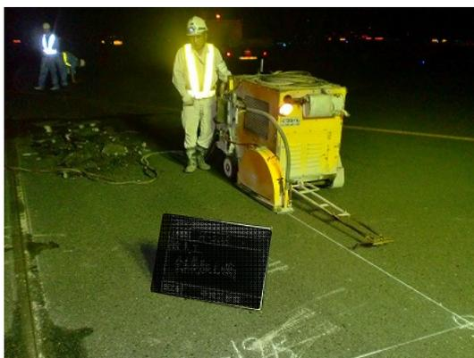
写真 5.1.4 舗装版切断状況
