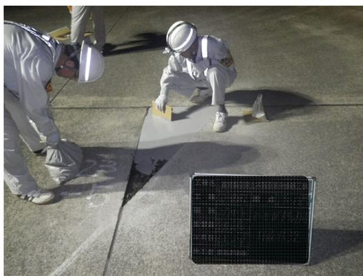
写真 5. 2. 2 樹脂モルタル打設状況
