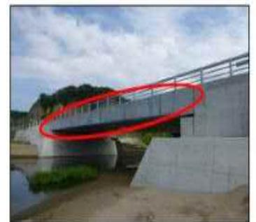
※地覆水切りが桁下まで打ち下ろされているため、横桁位置が確認できない。
