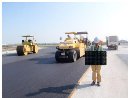
写真 5.2.8 アスファルト舗装転圧状況
