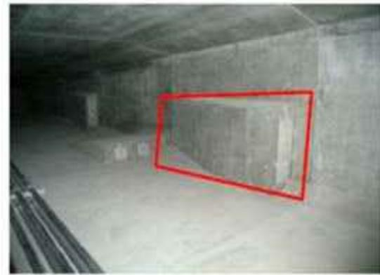
※本事例では、箱桁内の縦締めであるため、90番台とし、ウェブは91番とする。縦締めウェブの下2桁は、起点側からの定着突起の箇所数とする。このとき、両桁端部は箱桁内の定着突起状況を確認して要素番号を付けるか決定する。本事例では、端部に定着があると判断している。
