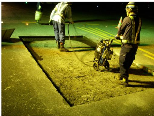
写真 5.1.6 タックコート散布状況
