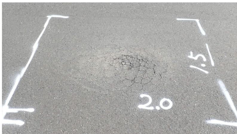
写真 4.2.6 点検記録写真（ひび割れ撮影例）
