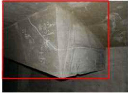
※本事例では、箱桁内の縦締めであるため、90番台とし、上床版は93番とする。縦締め上床版の下2桁は、起点側からの定着突起の箇所数とする。
