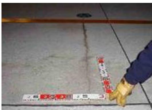
写真 3.1.17 ひび割れ（横断方向）
