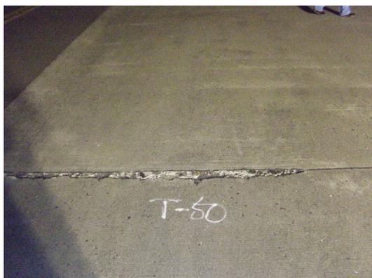
写真 3.1.23 目地部の破損
