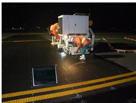
写真 5.1.12 グルーピング施工状況
