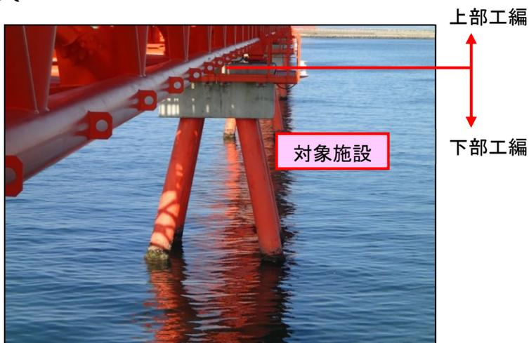
【那覇空港】・北側進入灯(滑走路側) 杭式(海底地盤上：コンクリート構造物のみ)
