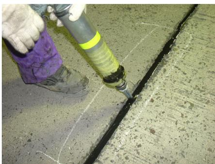
写真 5.2.3 目地材の注入状況
