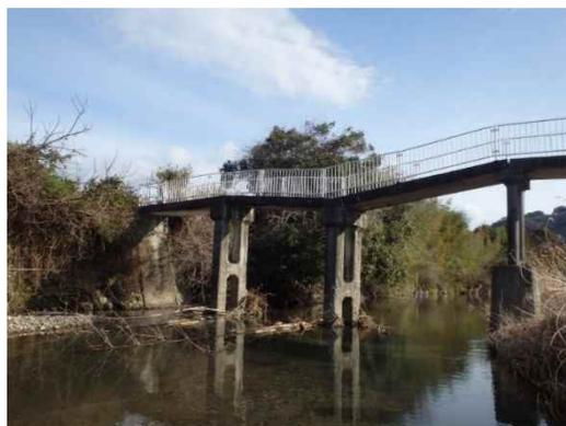
③パイルベント橋脚の腐食や座屈，ひび割れ
