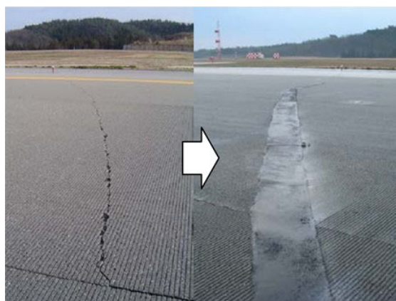
図-4. 2 ゼロ摺り付けによる応急復旧の例（2007年能登空港）
