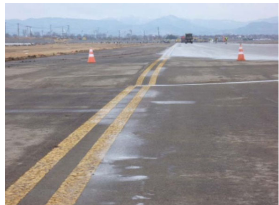
写真－２． ２ 【基礎地盤の液状化による局所沈下】の例 (誘導路本体と誘導路ショルダーの境界の路面標識に乱れがある)
