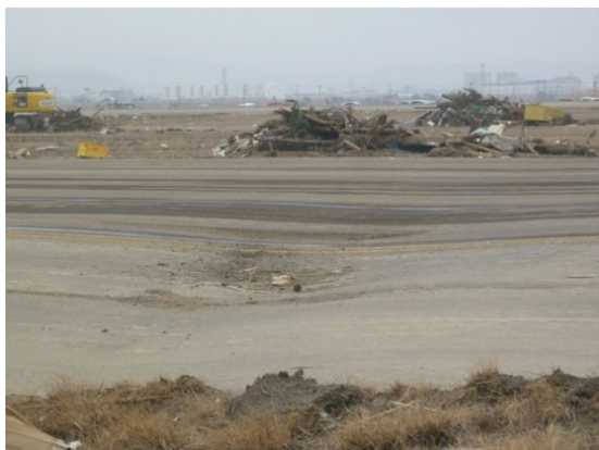
写真－２． ２ 【基礎地盤の液状化による局所沈下】の例 (誘導路本体と誘導路ショルダーの境界の路面標識に乱れがある)
