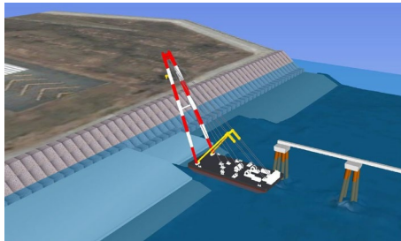
既設消波ブロック撤去
