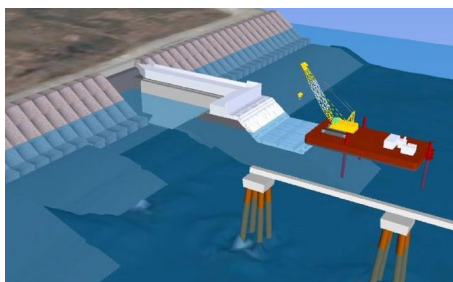
被覆ブロック設置
