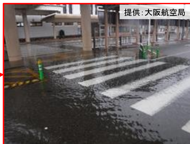
【 構内道路の冠水状況 】
