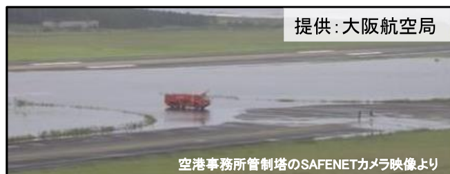
【S5誘導路付近の冠水状況】
