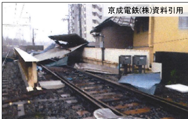
【成田駅構内(家屋倒壊・軌道内支障)】
