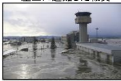
水没した空港事務所
