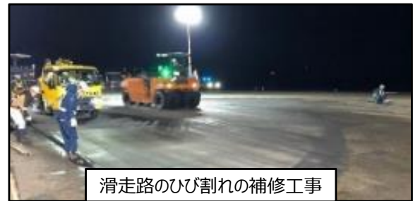
災害復旧工事（応急復旧）の例
