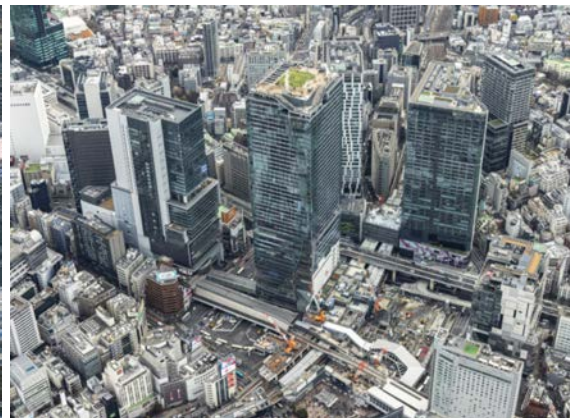
緊急離着陸場
