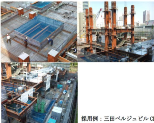
採用例：三田ペルジュビル CFT 柱
