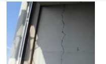
運航管理局舎外壁(亀裂)
