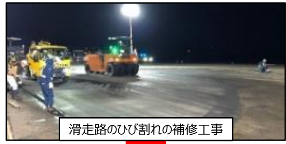
災害復旧工事（応急復旧）の例
