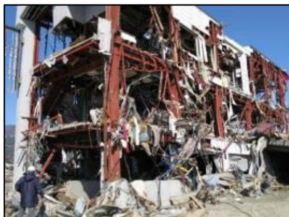
全面的な内外装の破損・流失
