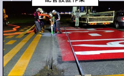
配管設置作業
