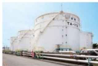
(貯蔵タンクの定期点検)
