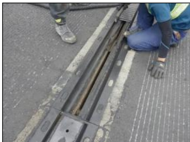
鋼製部材撤去完了
