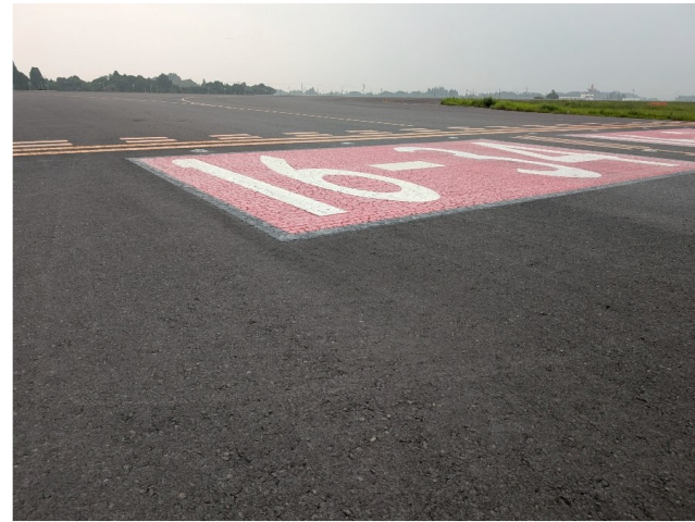
誘導路(除灰完了)
