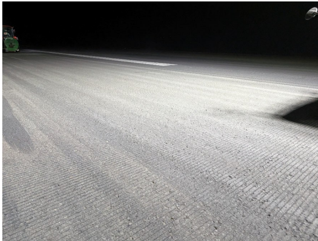
滑走路(除灰作業前)
