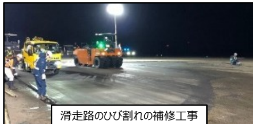
災害復旧工事（応急復旧）の例
