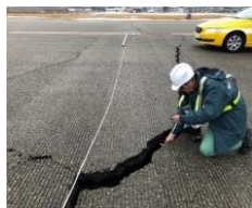
空港基本施設（滑走路等）の調査
