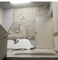
空港建築施設の調査
