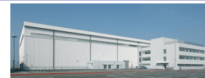
飛行検査センター庁舎・格納庫
