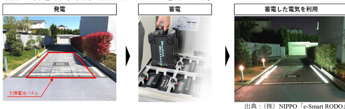
図 4-27 路面型太陽電池の活用モデル
