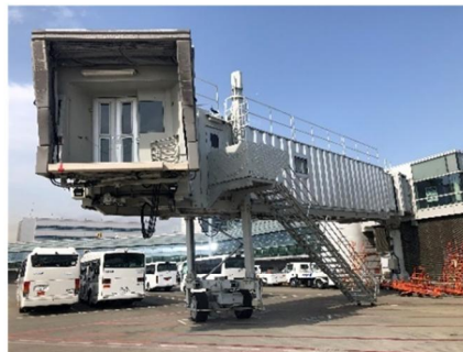
図：放射冷却素材を用いたフィルムを施工された PBB
