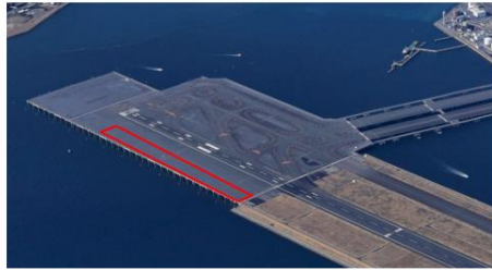
羽田空港D滑走路着陸帯 8 (舗装部)
