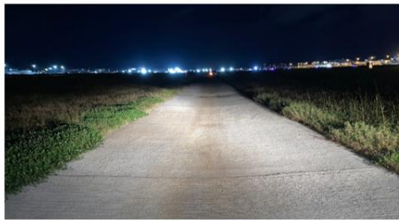
着陸帯Ⅱ (皿形排水溝)
