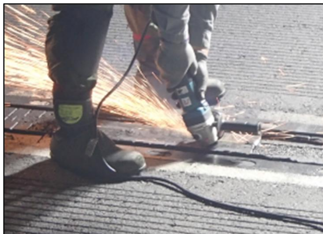
鋼製部材切断・撤去
