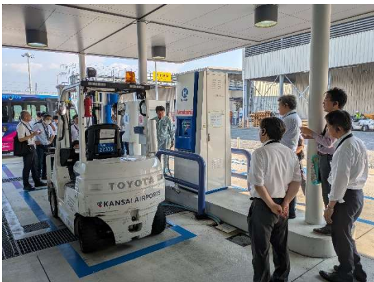
水素ステーション
