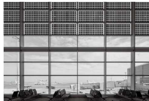
3階到着動線のガラス面に導入した「太陽光モジュール」
