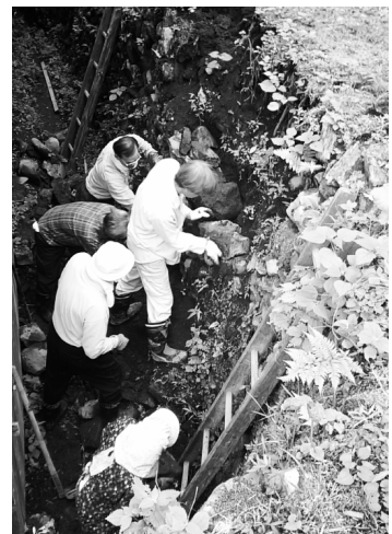
石垣の修復の様子
