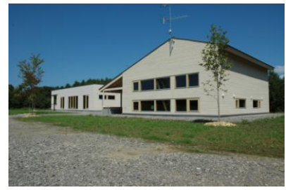
【H20 年度に新築された生活体験専用住宅】
