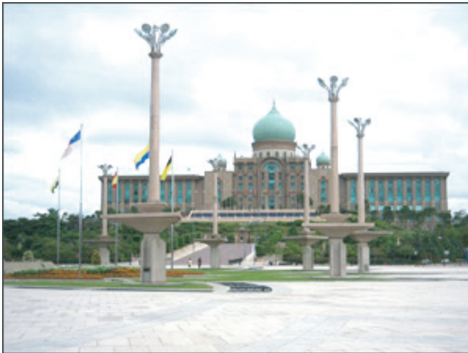
Prime Minister's Office (Putrajaya)
