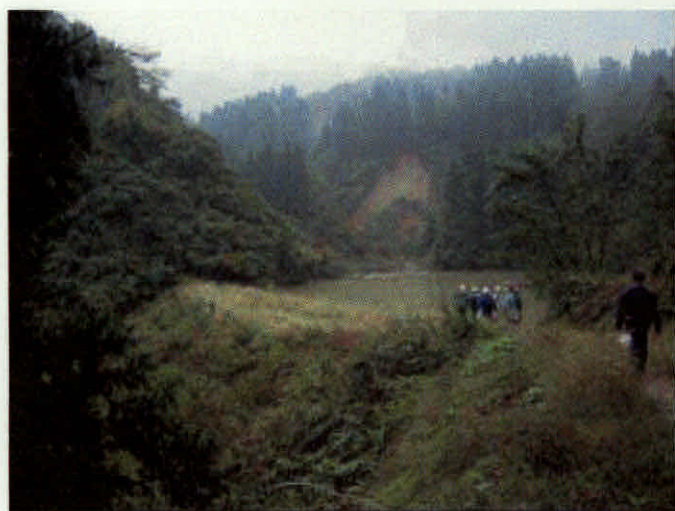
1. びわ崎池下流側からの全景(上流向こう岸に土砂崩れ(地すべり)が発生している。)
