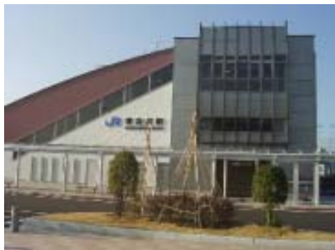
橋上駅舎化された東金沢駅
