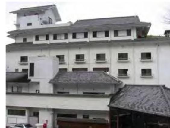
傾斜地で、下から見上げて圧迫感が生じないよう、棟を分割すると共に、傾斜地形をなじみやすい勾配屋根を用いる
