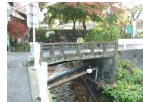
欄干の脇のガードレールを焦げ茶にし、管類を橋桁の下に抱かせて見えにくくするなどの景観対策により、茶褐色の黄金の湯が流れる河川やひなびた風情の感じられる橋、背後のモミジ等が引き立ち、水辺の景観が向上する。(八千代橋)
