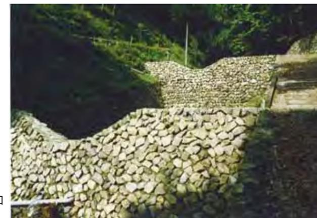
自然石張りによって景観への調和を図った砂防堰堤
