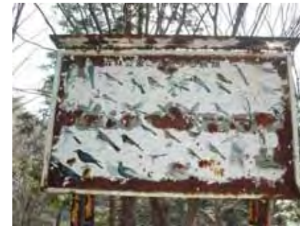
見本園付近のサイン:改修が必要。
