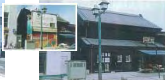
商店街の修景 / 上が修景前の姿
