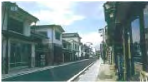
中町通り / 電線の地中化と歩道の整備
