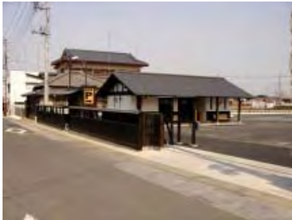
景観に配慮した駐車場の整備と公衆トイレの設置
