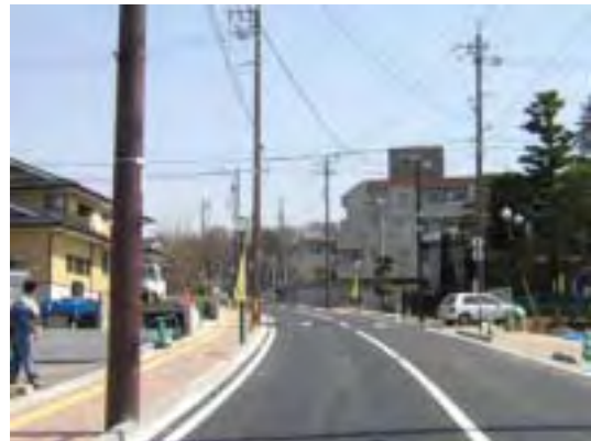
代替幹線道路(東郷土西原線平成17年3月一部開通)
