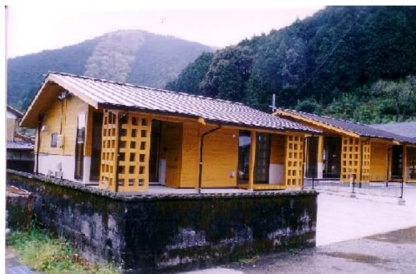
平成15年度に建設されたIターン者の定住住宅(大塔村)
