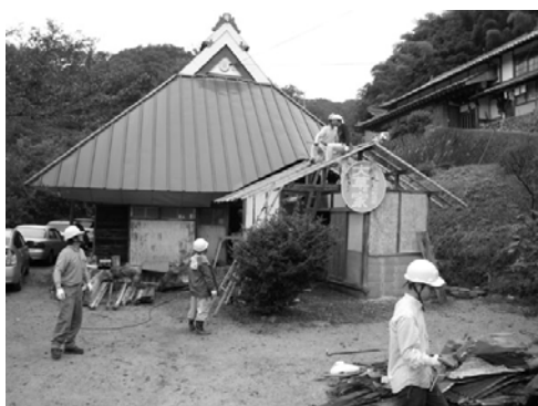
図表4-2-15 改修作業の様子
