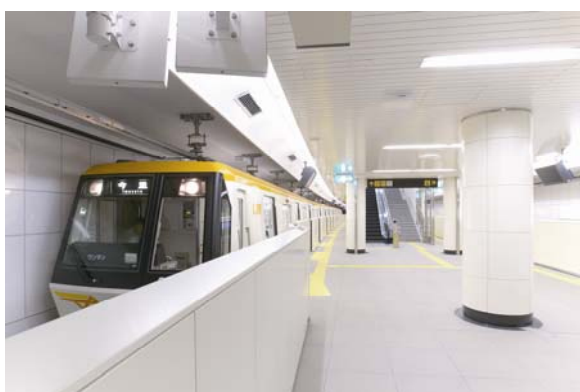
写真 開通した大阪市営地下鉄今里筋線
