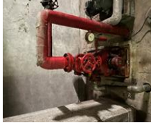
老朽化した消火ポンプの更新
