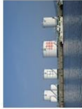
・ 離島の油槽所
