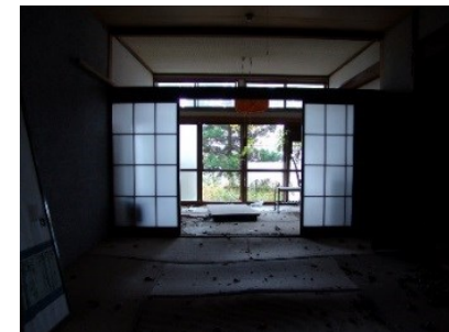
老朽化したホテル・旅館の改修
