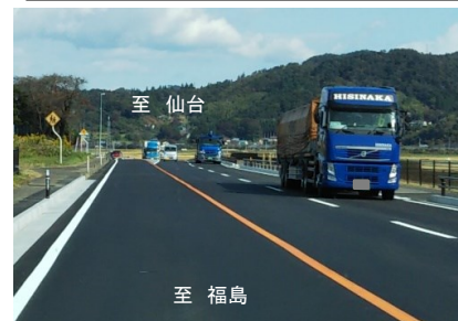
＜開通後の状況＞
