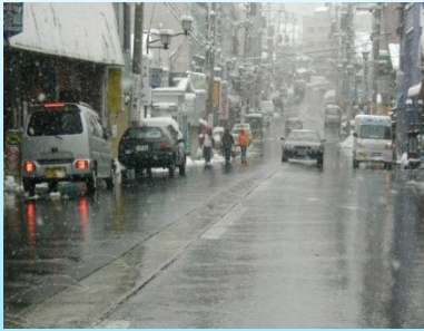
下水処理水を活用した消雪
