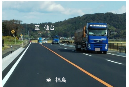
<開通後の状況>
