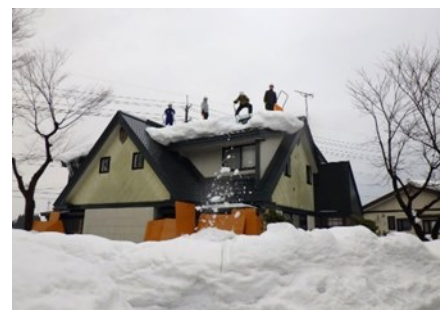
屋根雪下ろし作業の実施
